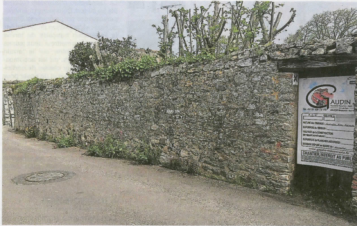
Une partie du mur traditionnel en pierres sèches.
