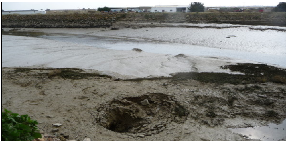
Effondrement étier de l'Arceau - Février 2009
