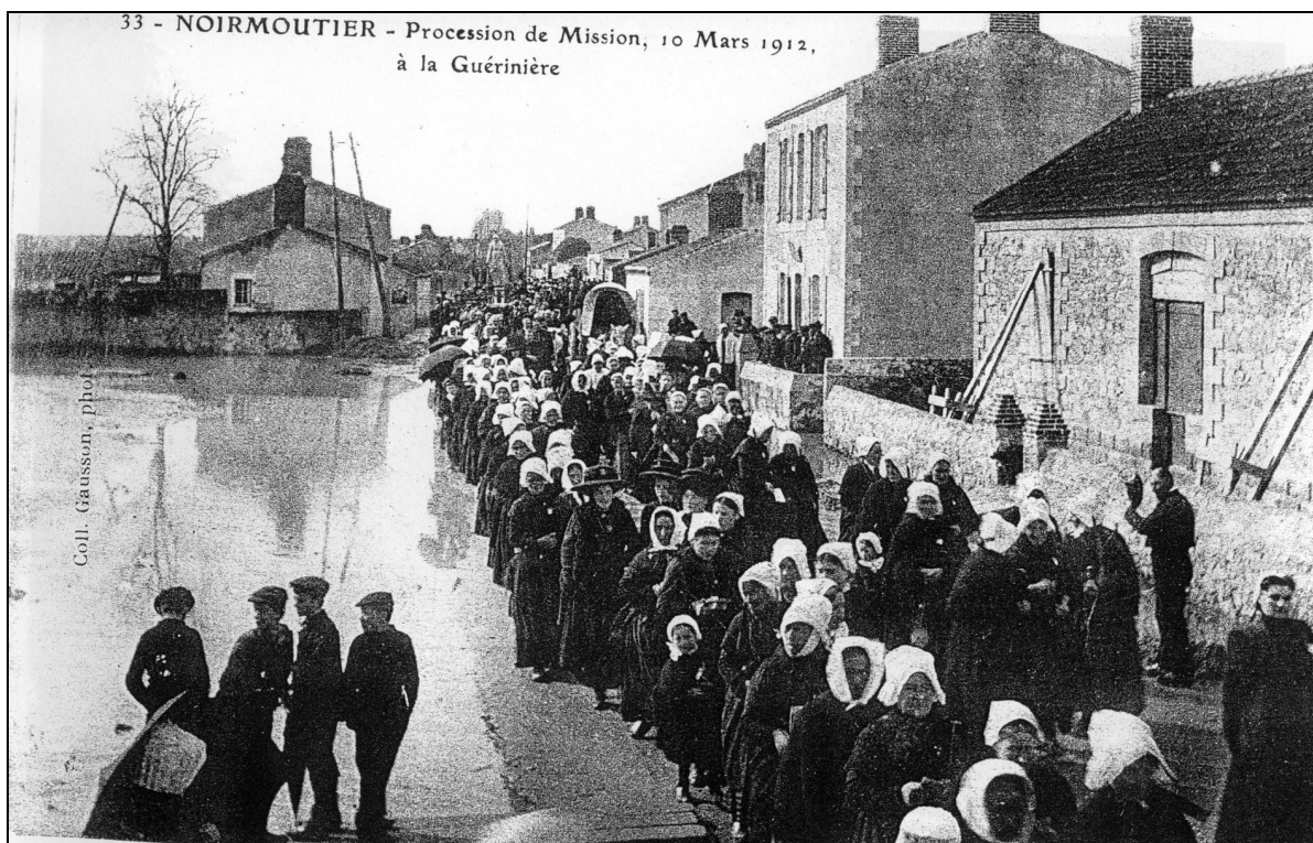
Zone inondée à gauche (place du Marché) à 2,6m NGF , maisons à droite à 3,00m NGF
