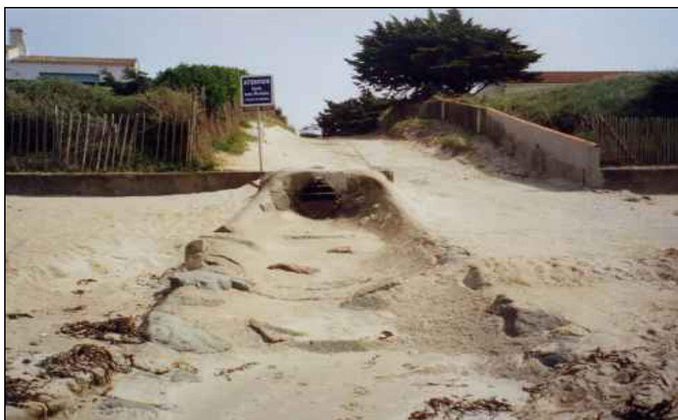
Coëf de la Linière rue de la plage, alimenté par une pompe électrique, C'est l'un des exutoires du bassin versant du nord de l'île.
