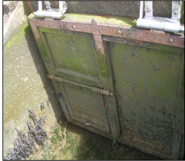
Porte de l'étier, chaussée Jacobsen (aujourd'hui reconstruite)
