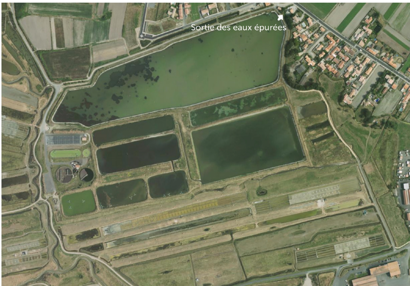
Station d'épuration des eaux usées de la Salaisière à Noirmoutier
