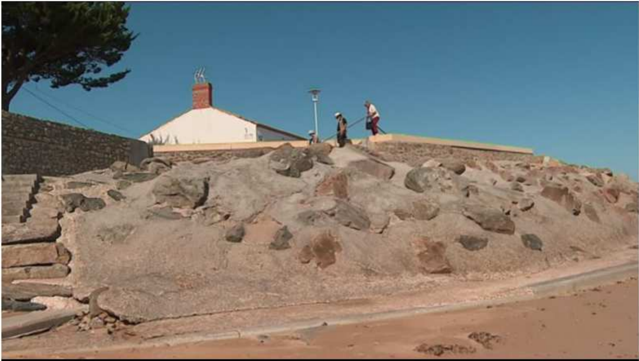
Des ouvrages de défense de la mer à Noirmoutier en Vendée / © France Televisions
