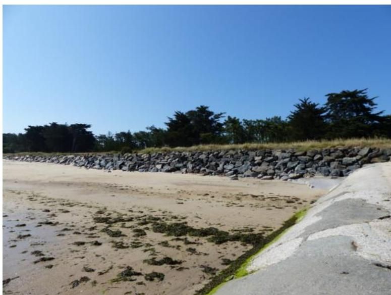
Cette dune située juste avant la zone urbanisée au nord (vers le Vieil) renforcée par un perré longitudinal et un perré en maçonnerie transversal, est sans aucun doute la zone la plus à risque de la plage de la Clère.
