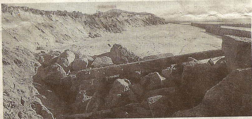
Secteur des Éloux où un rechargement en sable va être effectué afin d'assurer le maintien du trait de côte.
