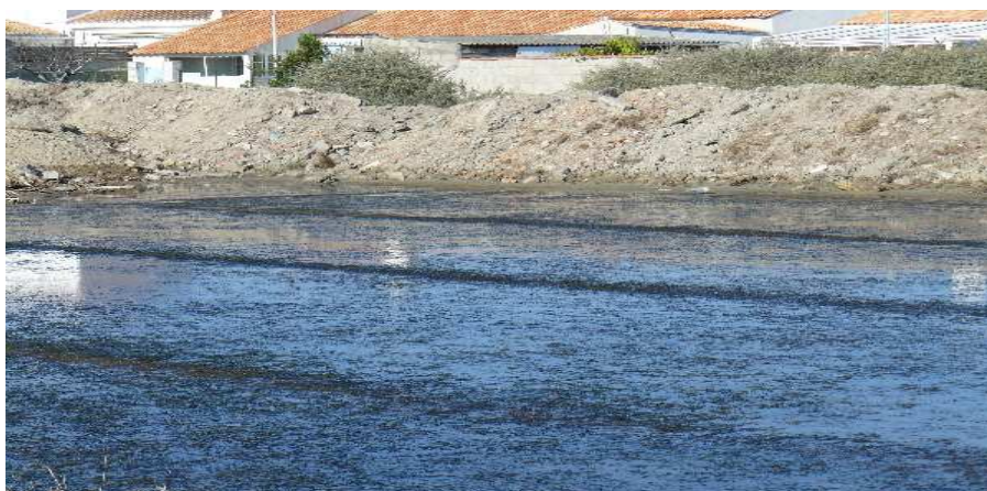
Marais du Pré au jonc – l'Épine – comblement partiel en 2007
