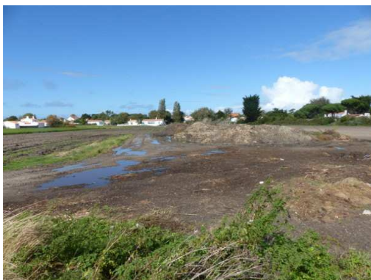
Prés Planches – Noirmoutier en l'Ile – 2015 Zonage PPRL – Rouge U » en voie de remblaiement !
