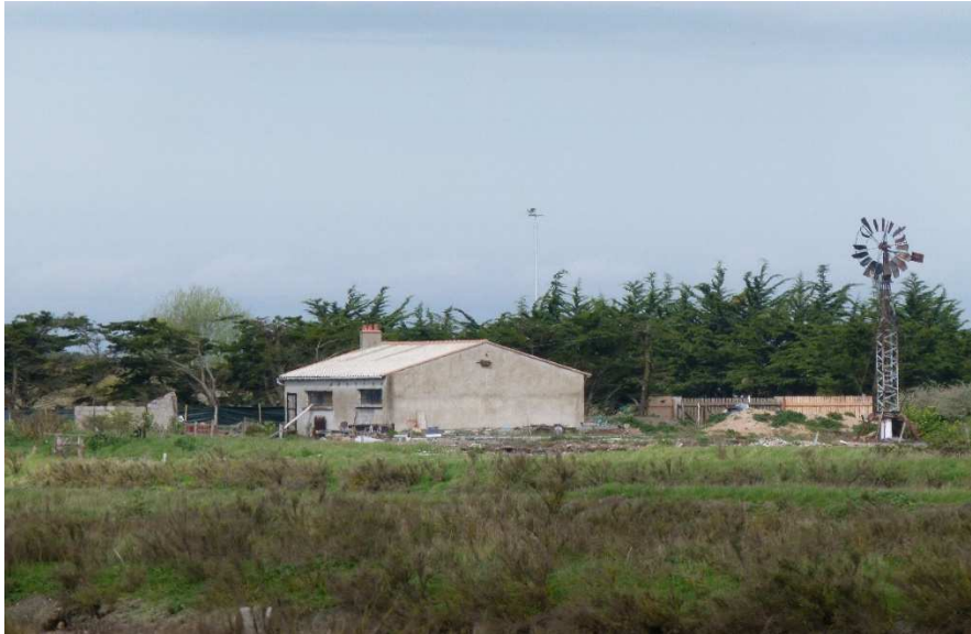
L'Epine – 2013 – Construction habitée (?) après remblaiement (?) légale ou illégale (?) (Zonage PPRL – Rouge N)
