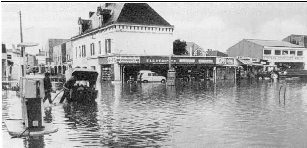
Janvier 1982 – Inondations centre-ville Noirmoutier en l'île (Actuellement, plusieurs pompes électriques vidangent en permanence dans l'étier du Moulin, la « bêche – réservoir » située sous les halles)
