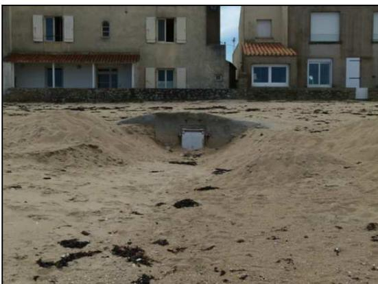
*1<sup>er</sup> Coëf d'évacuation des eaux pluviales bloquées à l'arrière de la dune bordière. On peut remarquer le muret de protection devant les habitations.*
