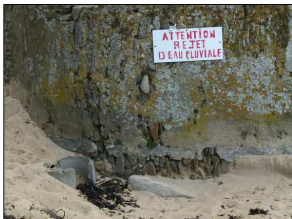
*Si le panneau indique bien un exutoire d'eau pluviale, peut-être alimenté par une pompe, ce système semble inopérant en l'état.*
